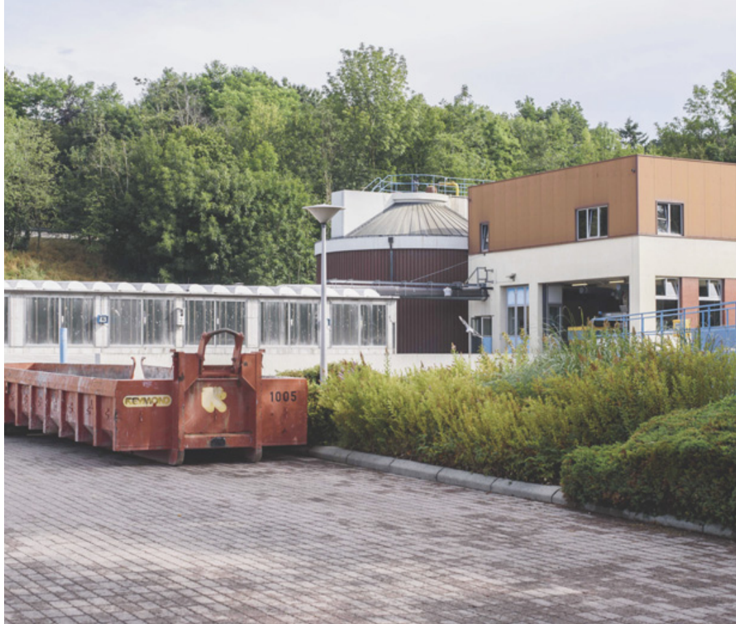
Opérés depuis le mois de mai, les travaux de maintenance de la step de la Dullive ont généré de fortes nuisances pour les habitants du secteur. CÉDRIC SANDOZ
